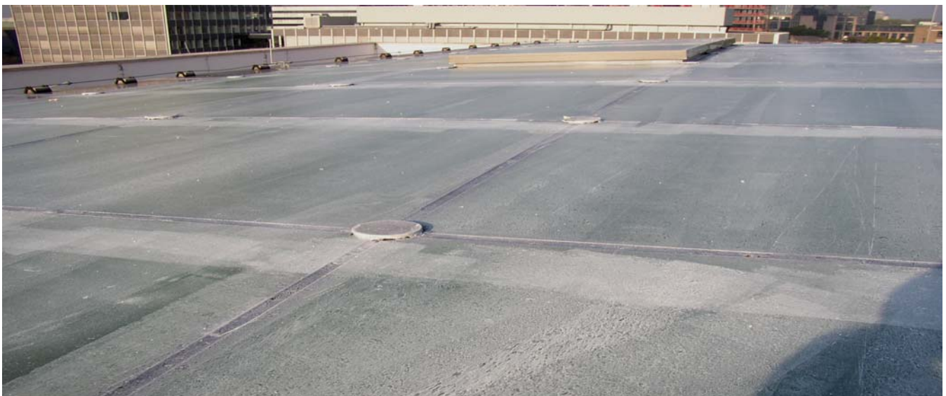
Beschichtung eines Glasdaches in der Innenstadt von Frankfurt am Main.
